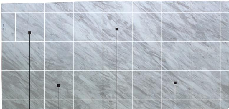
石は同じ原石から採りだした石でも、表面の柄模様・色の濃淡等が、どの場所も同じではありません。特に、石固有の柄模様が美しい変化を持ち、色の濃淡の差が大きい石種の場合、その素材の特長をいかした美しい仕上げをするため、施工前に仮置きして全体のバランスを確認することが大切なポイントになります。また、あまり柄模様の目立ちにくい白御影、赤御影、黒御影石等の場合でも、ロットにより色の濃淡や微妙な色調の差があり、遠目で見ると目立つ場合があります。やむなく追加注文の必要が生じた際、実際に現場で使用している石をお送りいただくなどして、確認をされてからのご注文をお願いします。
